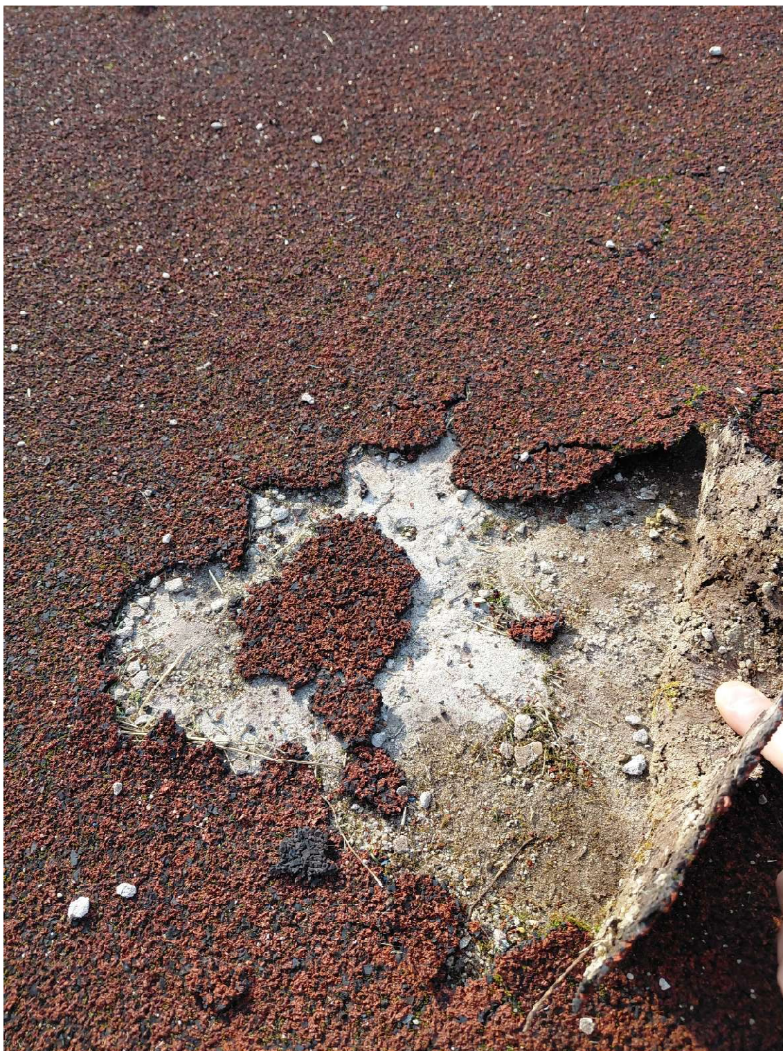
Fot nr 4 Spękania i ubytki na bieżni
