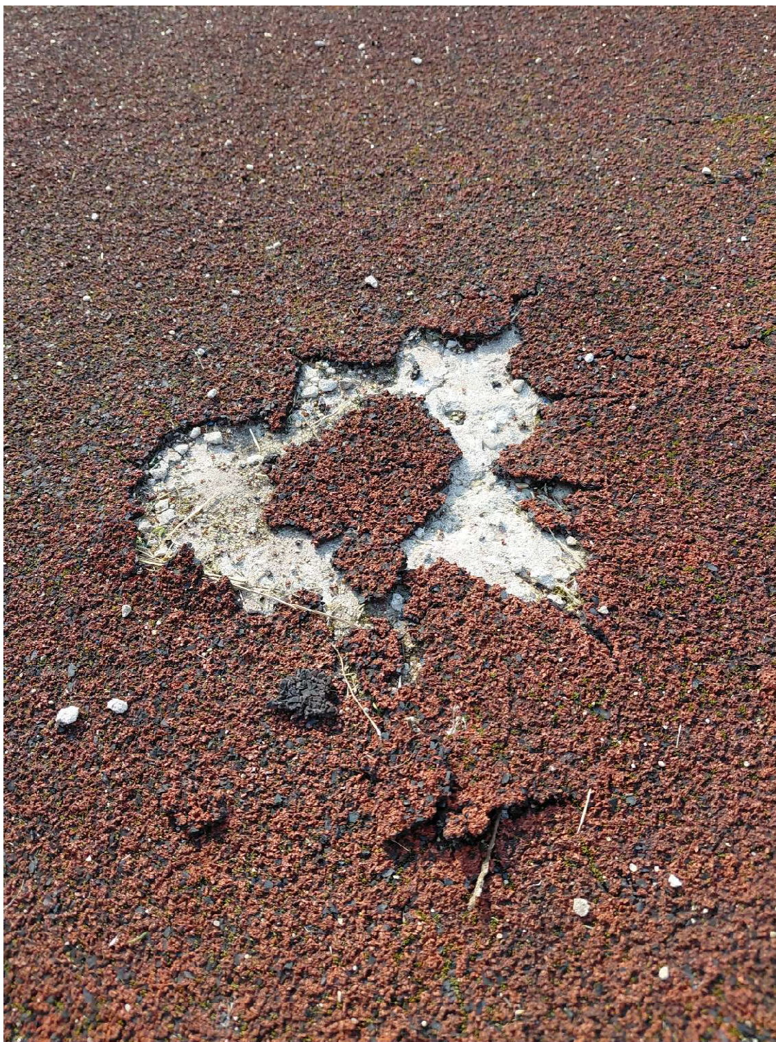
Fot nr 3 Spękania i ubytki na bieżni
