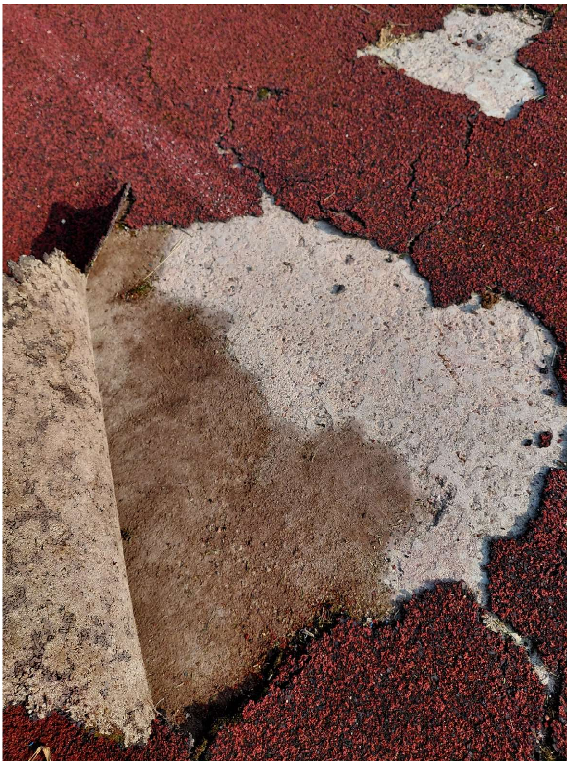
Fot nr 5 Spękania i ubytki na bieżni
